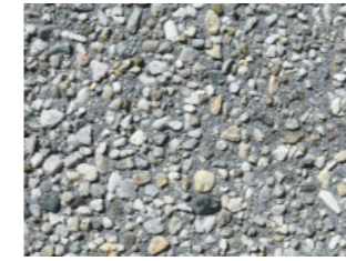
Waschbeton grob Beton
